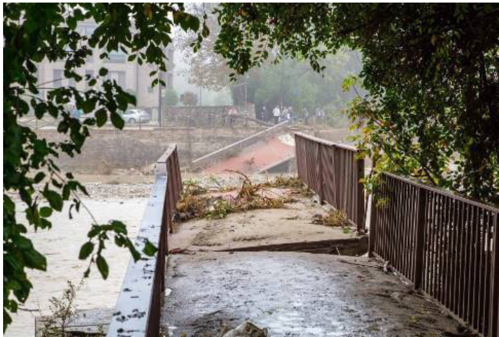
Figura 2.3: Crollo del ponte ciclopedonale “della Navetta” durante la piena del torrente Baganza del 13.10.2014.
